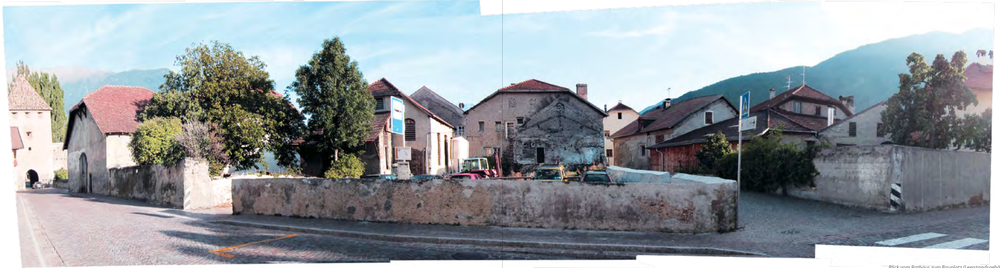
Blick vom Rathaus zum Bauplatz (Leerstandsgebäude links)
