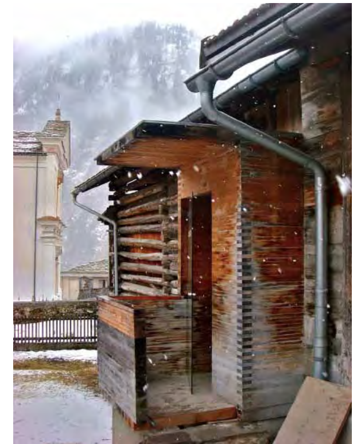
Abb.0103 Telefonzelle in Vrin von Gion A. Caminada
