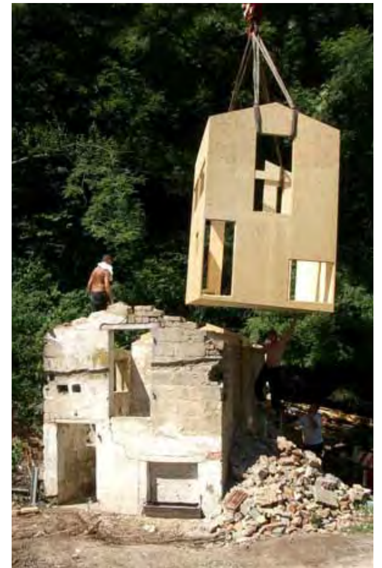
Abb. 0114 Montage S(ch)austall von naumann.architektur
